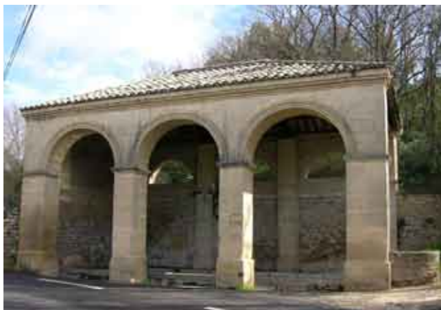
lavoir à Vers-Pont-du-Gard
