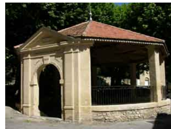
lavoir à Vers-Pont-du-Gard
