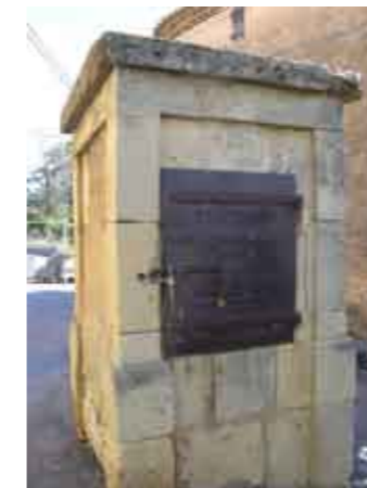
puits à la Bruguière
