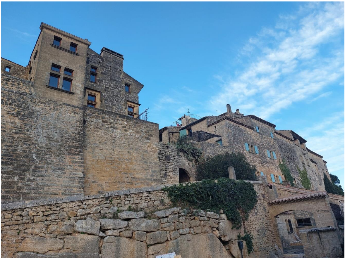
Vue sur Castillon-du-Gard © PETR Uzège-Pont du Gard
