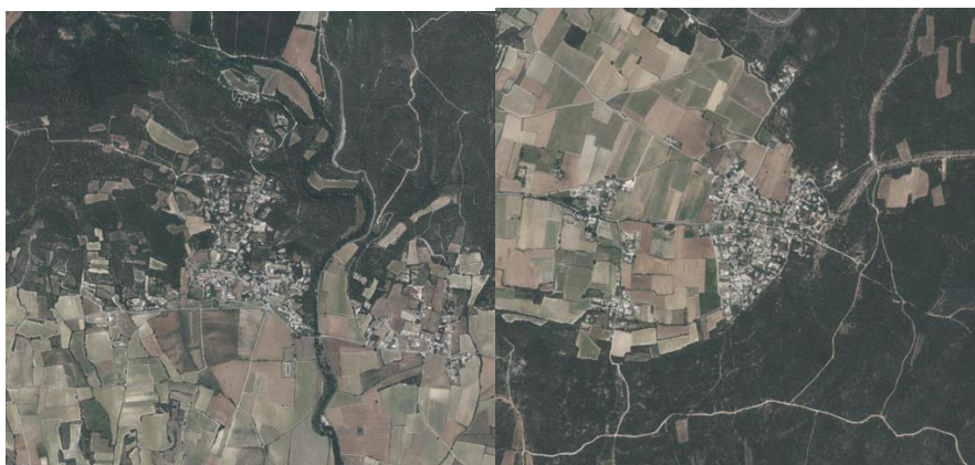
Village perché sur pente : Aubussargues à gauche, et Flaux à droite - Géoportail
