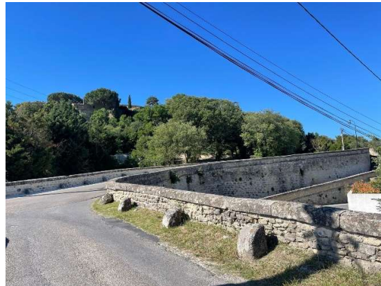
Entrée nord à requalifier
