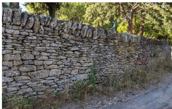
Muret traditionnel en pierres sèches présent dans tout le village
