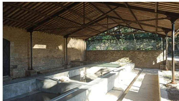
Lavoir à restaurer
